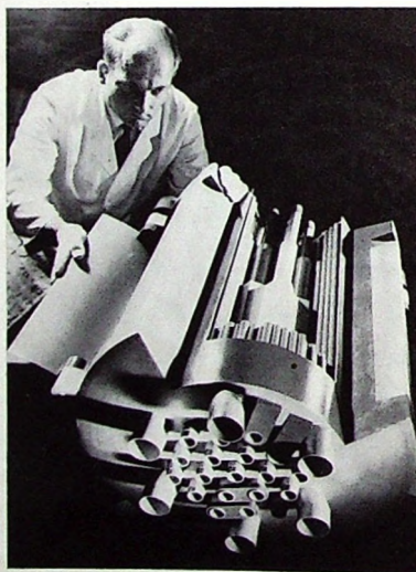
Modell des Incore-Thermionik-Reaktors zur Energieversorgung von Raumfahrzeugen
