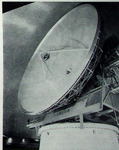
Bild 5. 25-m-Cassegrain-Parabolantenne der Erdefunkstelle Raisting I
